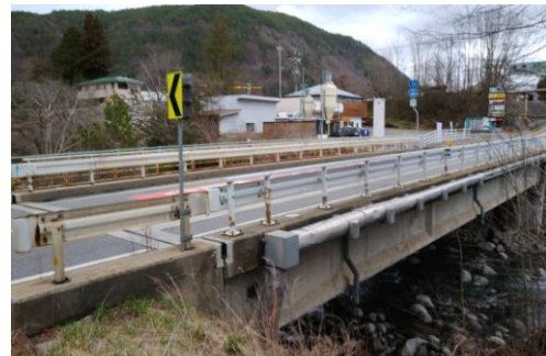
改修工事が予定されている七笑橋
