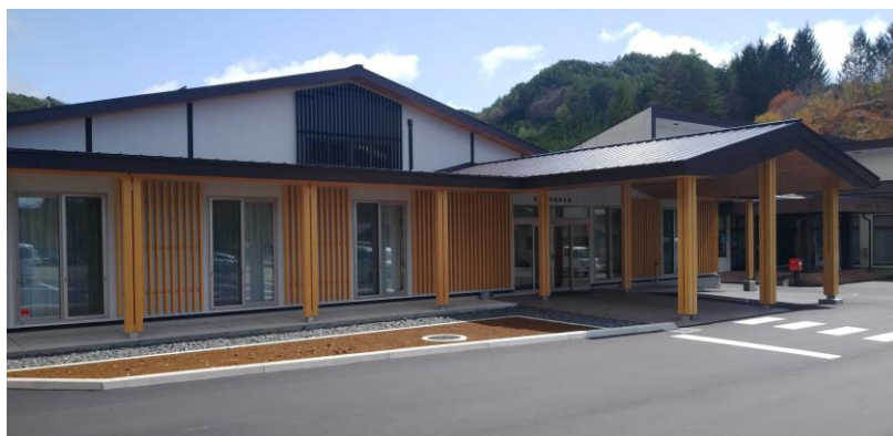
地元材をふんだんに使用した切り妻大屋根の木曽町開田支所
